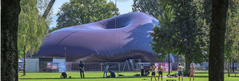
Bleibt dank permanenter Luftzufuhr aufgeblasen: Die Ark Nova in Luzern.
